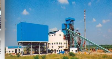
10 MW POWER PLANT FOR ETA POWERGEN
